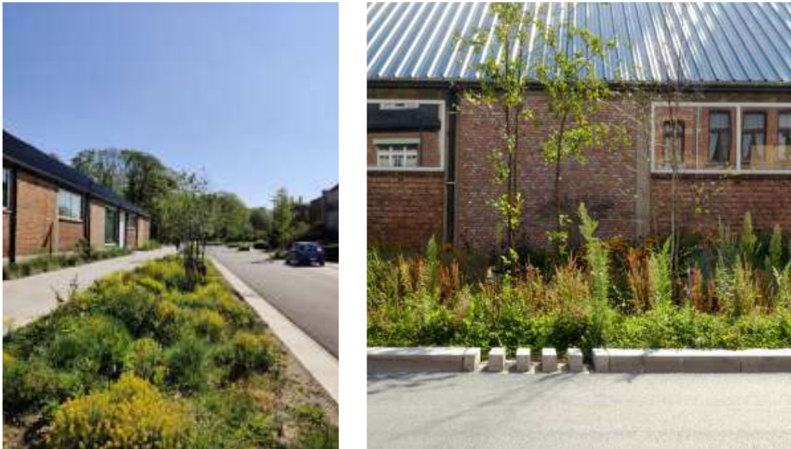
Figuur 39: Voorbeeld van een infiltratiekom naast de weg, en mogelijkheid tot afstroming van de verharding naar de infiltratiekom (bron: Blauwgroenvlaanderen.be; project in Mortsel)
