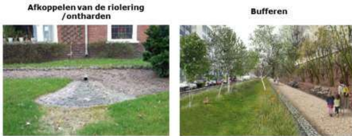
Figuur 5: Illustratie van hoe "afkoppeling van de riolering" of "buffering" in de praktijk gerealiseerd kan worden (bron rechts: Waterplan Antwerpen).
