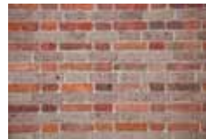
Westelijke zijgevel Sint-Janshospitaal met zgn speklaagmotief, een alterne- rende laag bakstenen en tufsteen © Cel Fotografie Stad Brugge, Jan Termont
