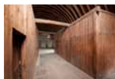
Broederzolder Sint-Janshospitaal met muren uit Baltische eik © Cel Fotografie Stad Brugge, Jan Termont
