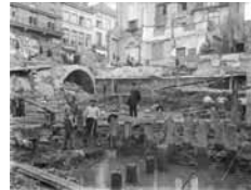
Anoniem, begin 20ste eeuw Graafwerken aan de markt waar voorheen de Waterhalle stond Brugge, Stadsarchief
