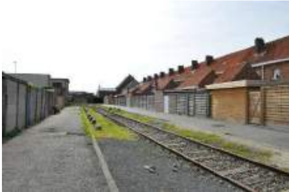
Spoorweg tussen Visserstraat en Kustlaan
