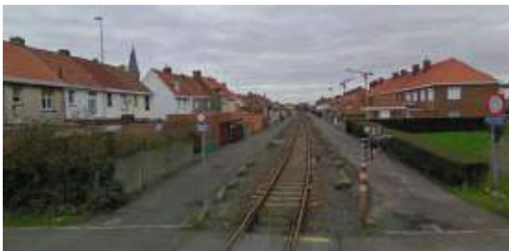
Foto 5-5 Spoor naar Zweeds Kaai vanuit de Wandelaarsstraat
