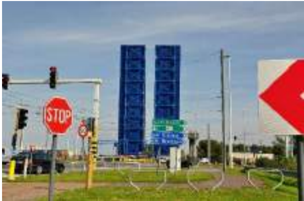
Brug aan Kustlaan (Oosten)
