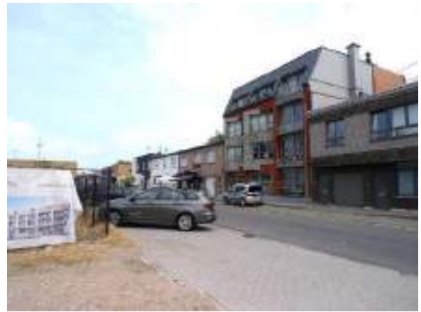
Bouwhoogte van 4 bouwlagen in de Wandelaarstraat.
