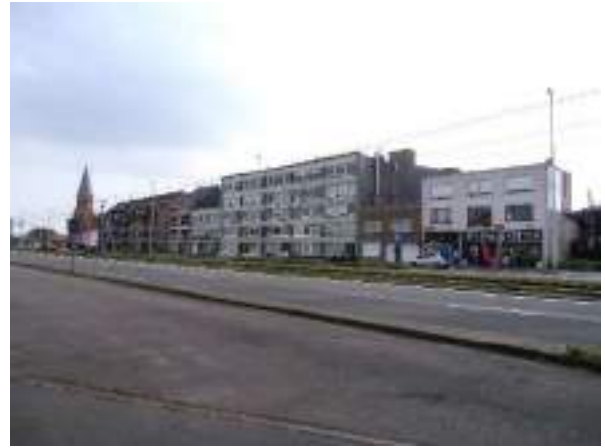
Verschillende bouwhoogtes langsheen de Kustlaan.
