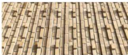
Referentie metselwerk op de zijwanden
