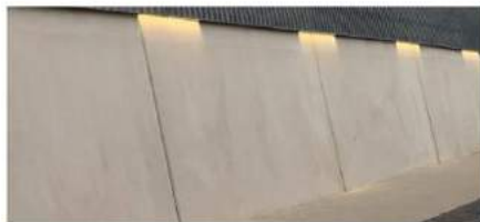
Referentie gepolijst beton op de zijwanden in de passage
