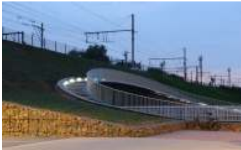
Referentie brug langs spoorwegbedding (Sneppebrug Gent, Samyn&Partners)
