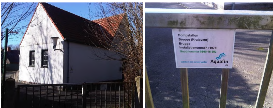
Fig.: het pompstation van Aquafin
