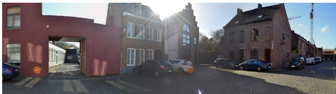
Fig.: Toegang tot de wasserij Dumalin, in de Haarakerstraat
