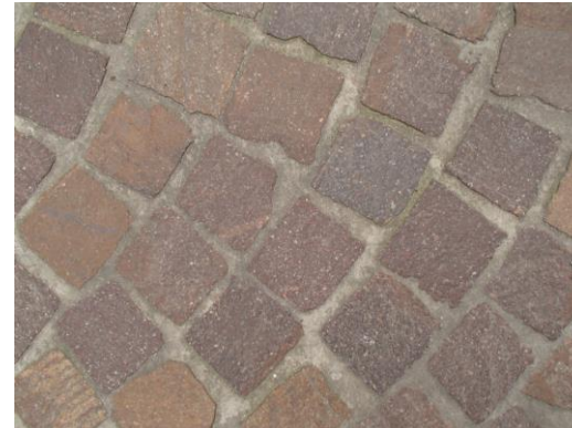
Mozaiekkeien uit rode graniet (uitritconstructies oa Hoogstraat, referentie Kelkstraat)
