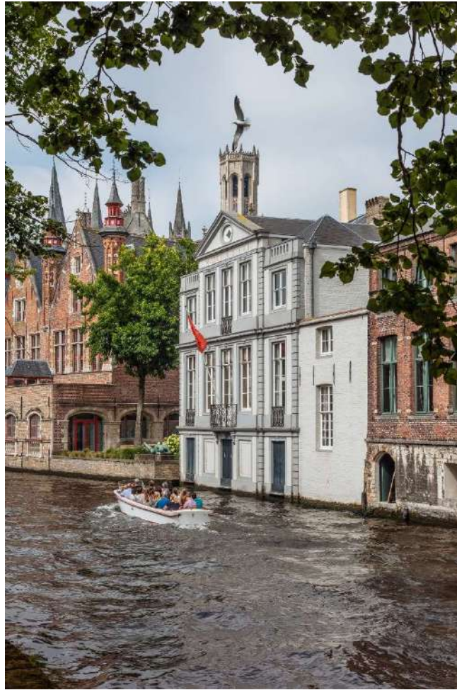
Figuur 15. Veel daken kunnen vaak rechtstreeks (of via een infiltratievoorziening) afgekoppeld worden naar de reien i.p.v. naar de riolering (bron foto: Stad Brugge).
